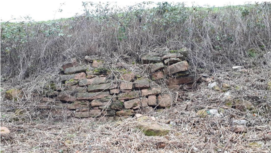
**Abb. 5 a (oben): starker Verbuschungsgrad der Terrassen als Folge der Bewirtschaftungsaufgabe; b (unten): eingestürzte Trockenmauer aufgrund des Wurzeldrucks der Verbuschung mit vorwiegend Brombeeren.**
