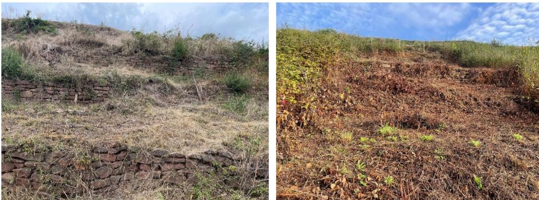
Abb. 12 a und b: Überwucherte, eingestürzte bzw. nicht mehr vorhandene Trockenmauern im Oberhang der Hundsrückterrassen.
