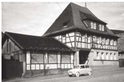
Hotel Stern vor der Renovierung
