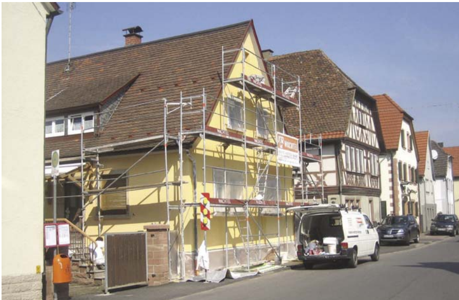
Sanierungsarbeiten am Anwesen Freudenberger Straße 33
